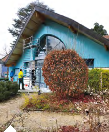
Chalet du Port, ravalement façades
