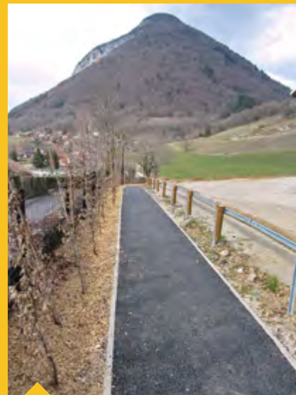
Enrobage du chemin piéton route des côtes
