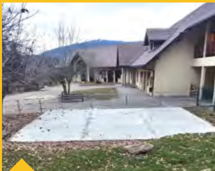
Rénovation de l'espace jeux de l'école publique du Clos Chevallier
