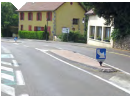
Pose de panneaux flexibles de signalisation
