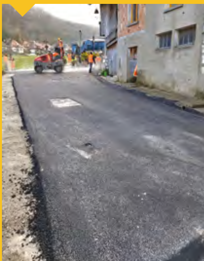
Enrobage de la chaussée carrefour route des Côtes - route de Ramponnet
