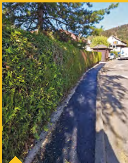
Réfection du trottoir devant le Clos de l'Avenir
