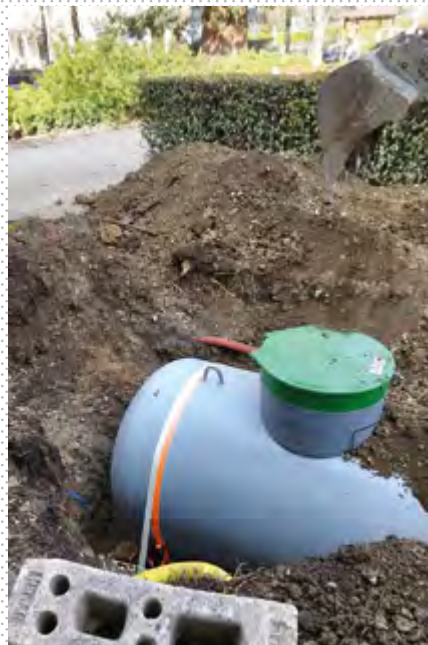
Construction du local poubelles du Chalet du Port. Avant de couler la dalle, il a fallu déplacer la cuve à gaz.
