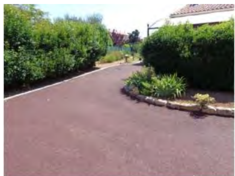
Allée/parking en enrobé poreux (source : Celtivia)
