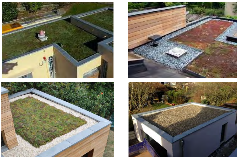
Exemples de toitures stockantes (végétalisées ou non)
