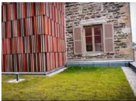
Toiture végétalisée (source : Grand Lyon)
