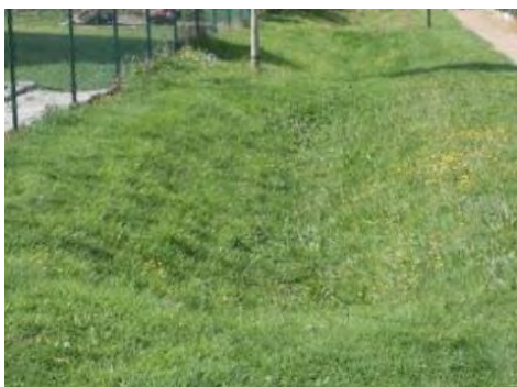
Noue en bordure d'allée (source : Alise Environnement)
