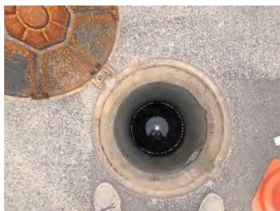
Puits d'infiltration
